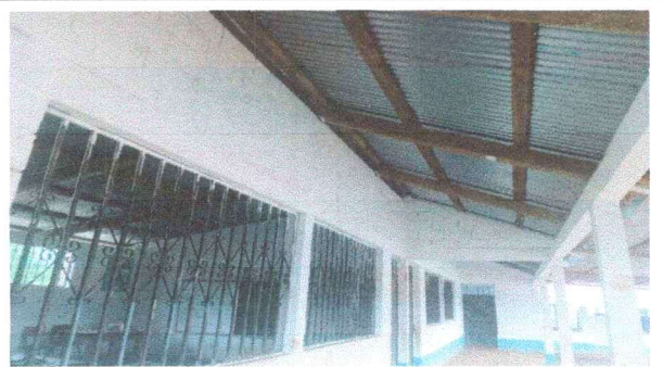
Foto 4: En la fotografía da a conocer el mantenimiento de balcones y de las 8 ventanas.
