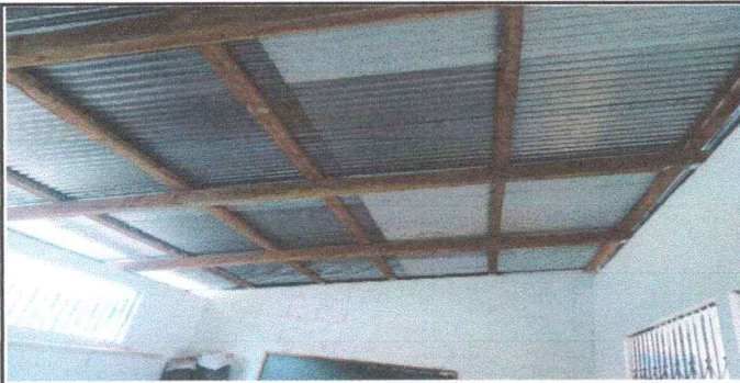
Foto 1: La fotografía evidencia el cambio del entechado de aula 1 y 2.
